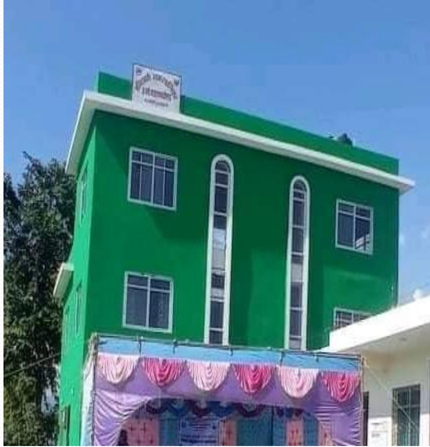
वडा प्रशासनिक भवन वडा नं. ३
